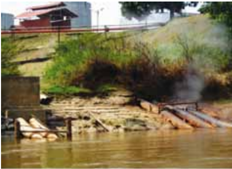
Vista del vertimiento de las aguas de producción al río Corrientes antes de julio del 2008.
