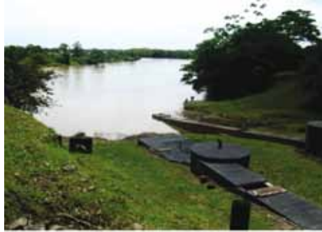
Vista del "vertimiento cero" en el río Corrientes a partir de agosto del 2008.
